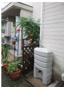
↑ 雨水タンク まる 140
