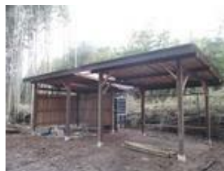
↑完成した炊事小屋
