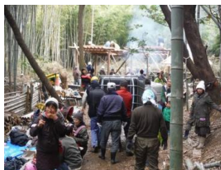
↑小屋づくりと雨水タンク設置
