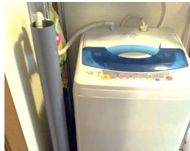
↑雨水を宅内に引き込んで洗濯に（湖南市N邸）
