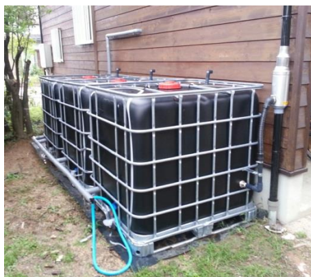
洗濯やトイレに使える大型雨水タンクの設置
