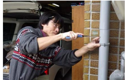
雨水タンクの設置工事
