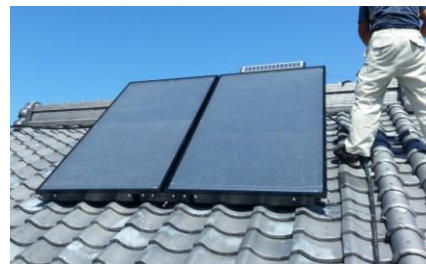
太陽熱温水器の設置
