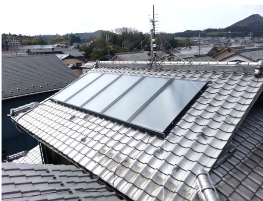
福祉施設での太陽熱利用機器設置（小規模多機能型居宅 介護 秋桜舎／株式会社なんてん協働サービス／湖南市）
