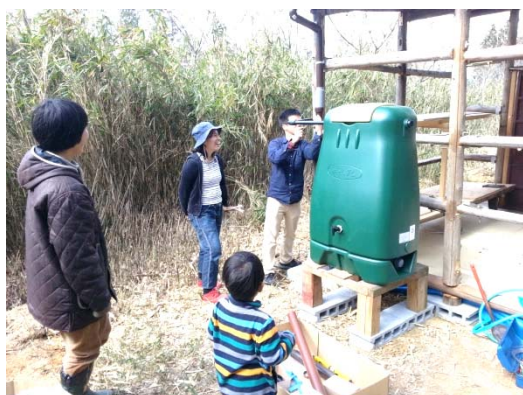
みんなで雨水タンク設置（森の遊び場 in 日野）
