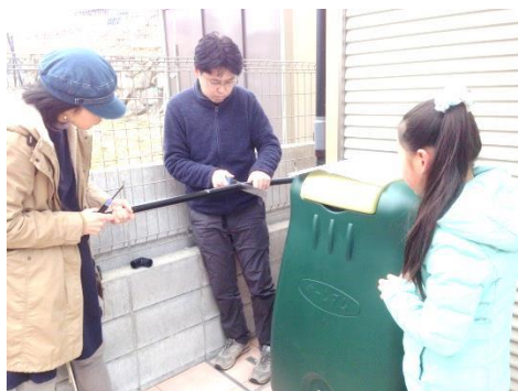
住まい手ご一家での雨水タンク設置（大津市）
