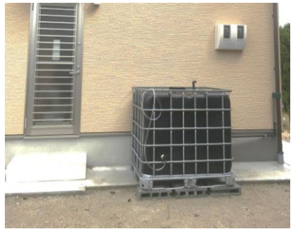
自治会館の防災設備として、雨水タンクを設置（湖南市・菩提寺）
