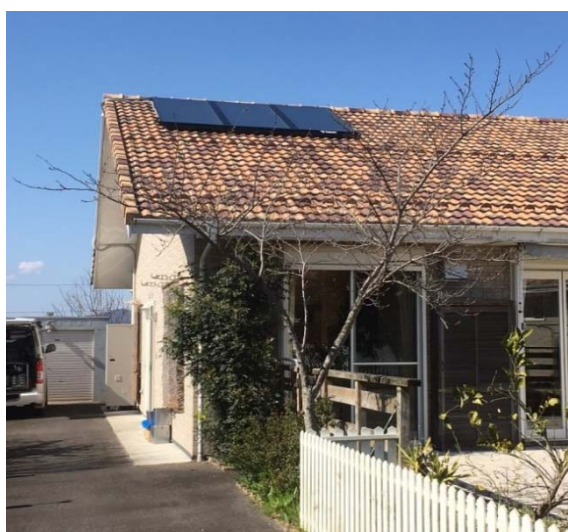
グループホームの入浴用にソーラーシステム（太陽熱利用機器）を設置しました（近江八幡市）
