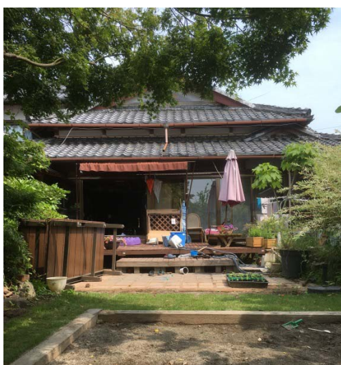
障害のある人も暮らす歴史ある住まいの、屋根の修繕工事を行いました（日野町）
