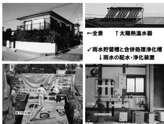
写真-3 鈴木家の増改築工事
